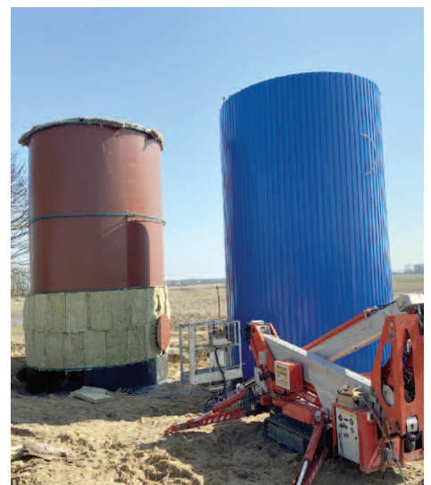
Budowa zbiorników do magazynowania wody w Ceradzu Dolnym
