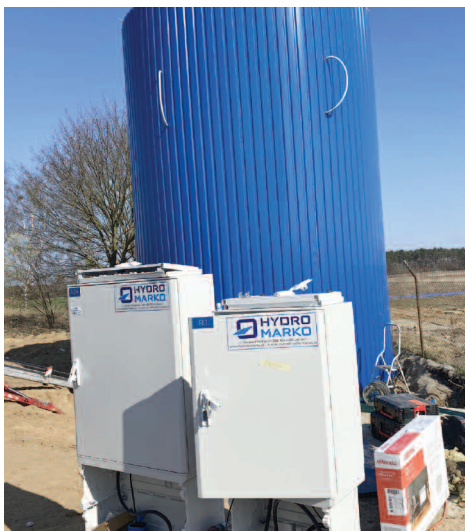
Budowa zbiorników do magazynowania wody w Ceradzu Dolnym
