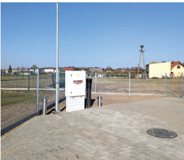
Kanalizacja sanitarna Podrzewie-Duszniki
