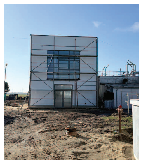
Rozbudowa oczyszczalni ścieków w Dusznikach
