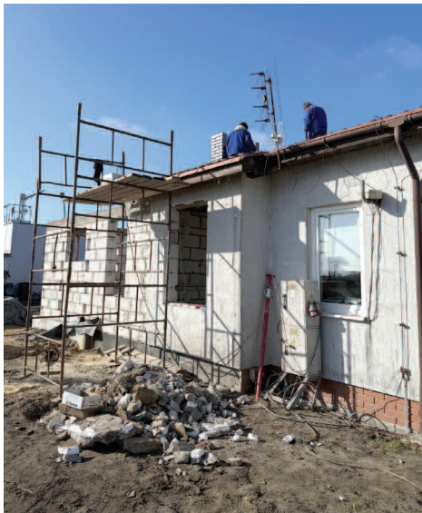
Rozbudowa oczyszczalni ścieków w Dusznikach
