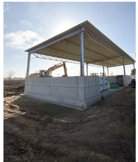
Rozbudowa oczyszczalni ścieków w Dusznikach
