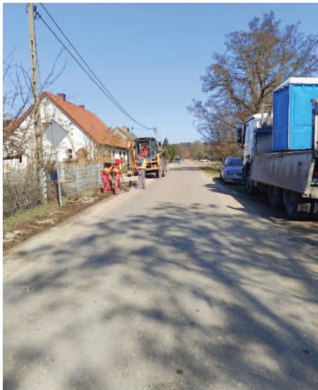
Budowa chodnika w Mieściskach
