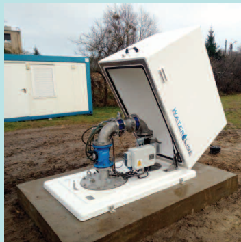
Modernizacja studni głębinowej w Dusznikach
