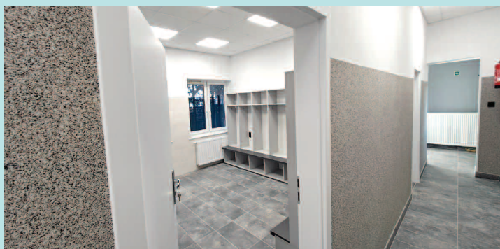
Szatnia na medal - remont zaplecza szatniowego w Dusznikach przy ul. Sportowej 2
