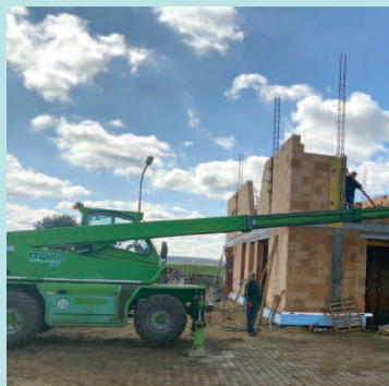
Modernizacja i rozbudowa oczyszczalni ścieków w Dusznikach
