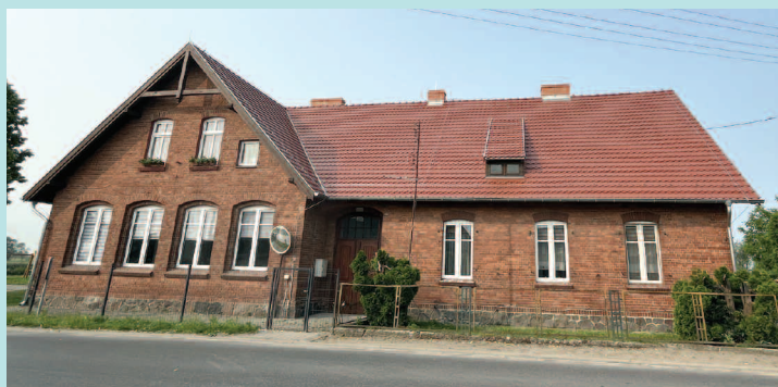
Remont dachu w Grodziszczku
