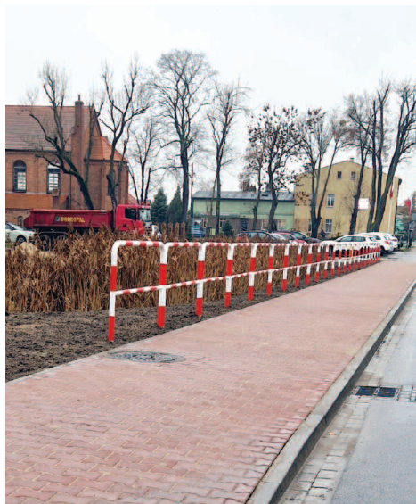
Chodnik na ul. Powstańców Wlkp. w Dusznikach
