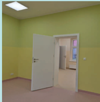
Remont budynku szkoły w Podrzewiu
