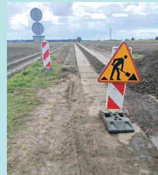
Utwardzenie ulicy Topolowej w Sędzinku
