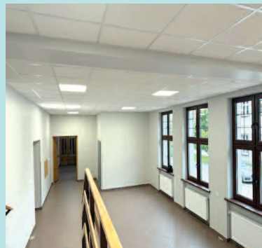
Remont Centrum Animacji Kultury w Dusznikach
