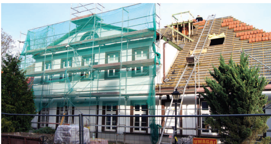
Remont dachu dworku w Duszniakach
