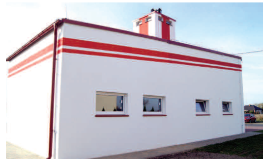
Przebudowana część garażowa strażnicy w Duszniakach
