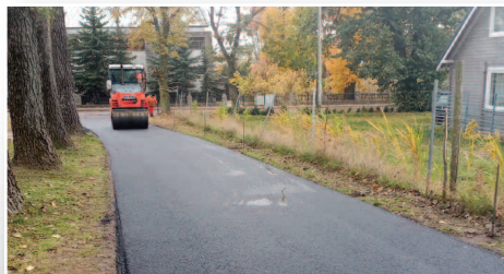
Remont drogi w Sędzinach - str. 5
