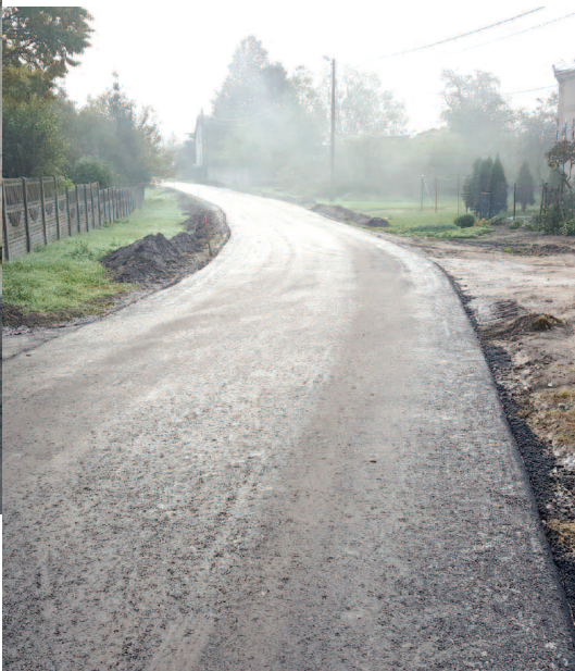
Droga w Zakrzewku
