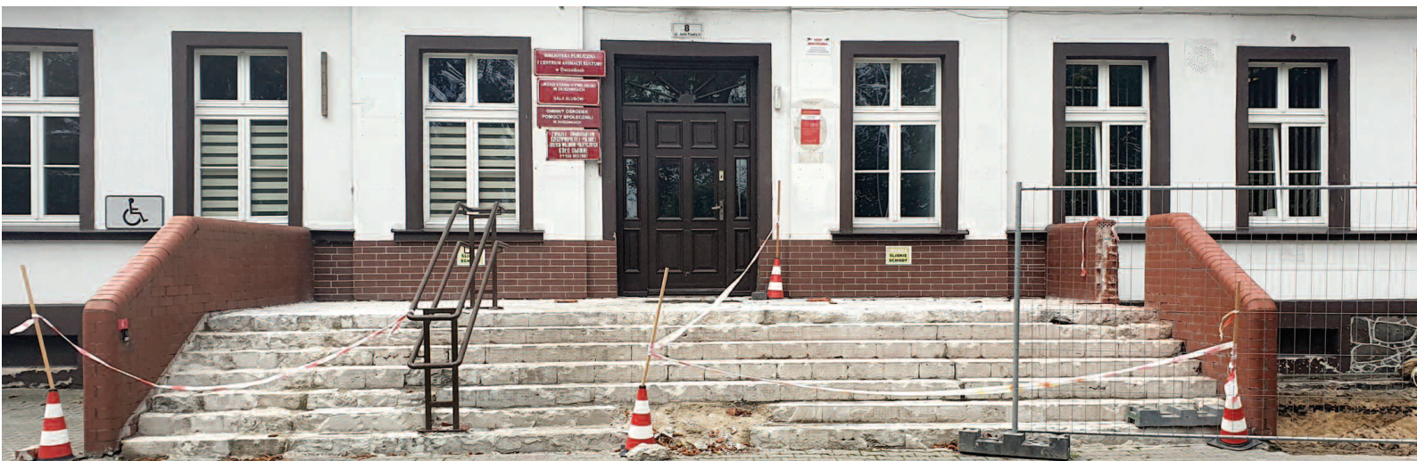
Stan prac na początku września 2020 r.
