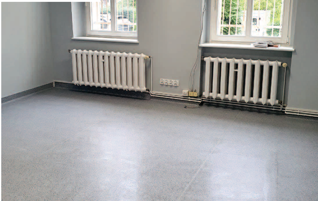
Nowe pomieszczenie w urzędzie po zakończeniu prac remontowych
