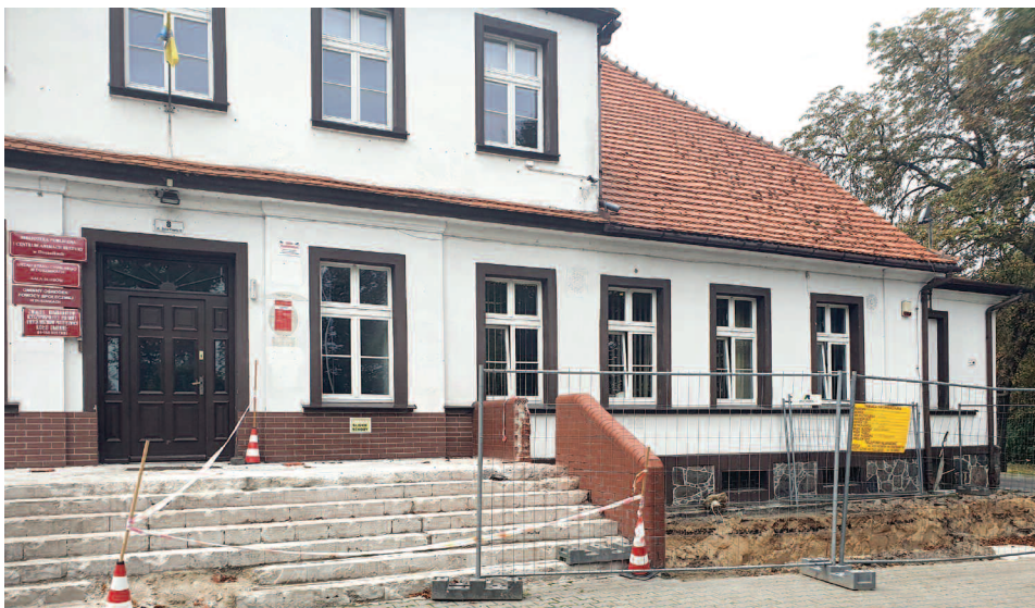
Wykop pod podjazd dla niepełnosprawnych
