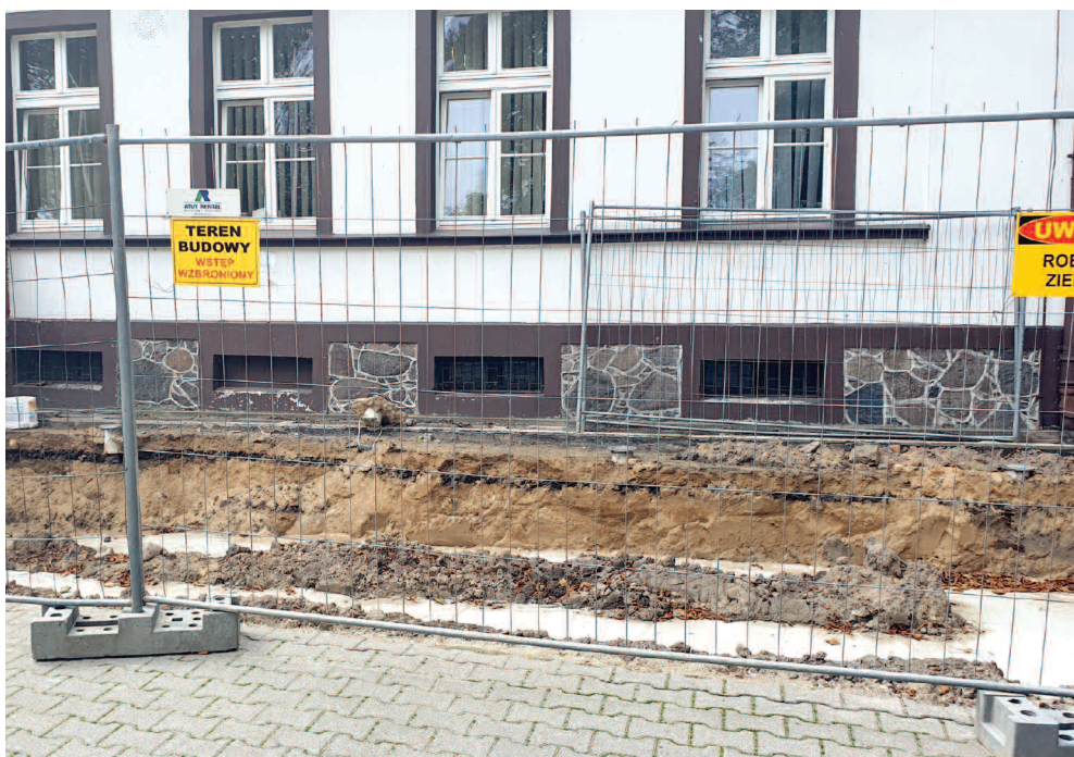
Wykop pod podjazd dla niepełnosprawnych
