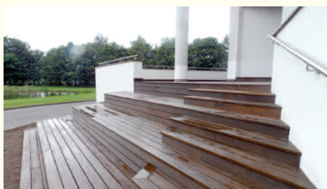
Taras i schody budynku CAK w Dusznikach
