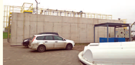
Rozbudowa oczyszczalni ścieków w Grzebienisku
