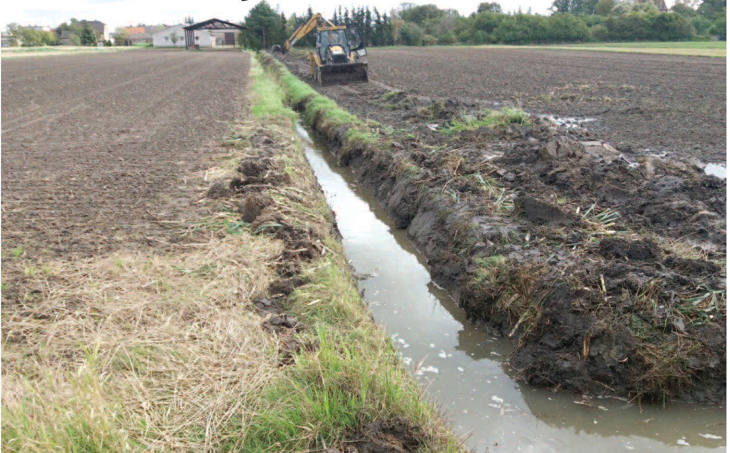
Prace przy rowie w Dusznikach na odcinku między ul. Jana Pawła II i ul. Kolejową
