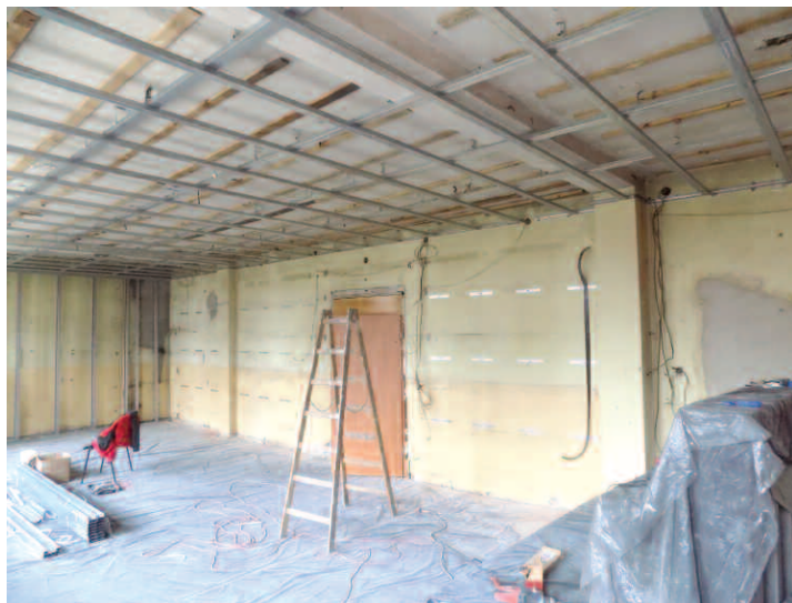
wykonanie podwieszanego sufitu oraz zamontowanie płyt gipsowo-kartonowych.
