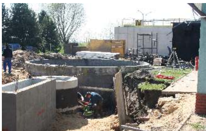
Rozbudowa oczyszczalni ścieków w Grzebienisku
