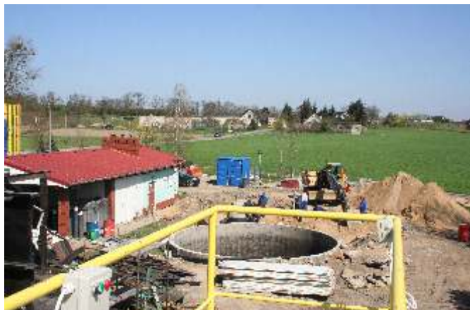
Rozbudowa oczyszczalni ścieków w Grzebienisku
