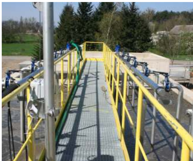
Rozbudowa oczyszczalni ścieków w Grzebienisku
