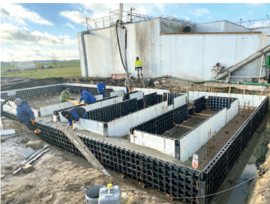
Rozbudowa oczyszczalni ścieków w Dusznikach
