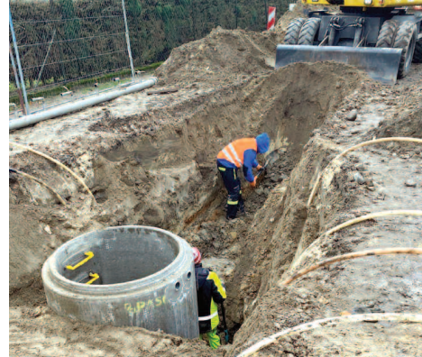
Budowa kanalizacji Podrzewie-Duszniki
